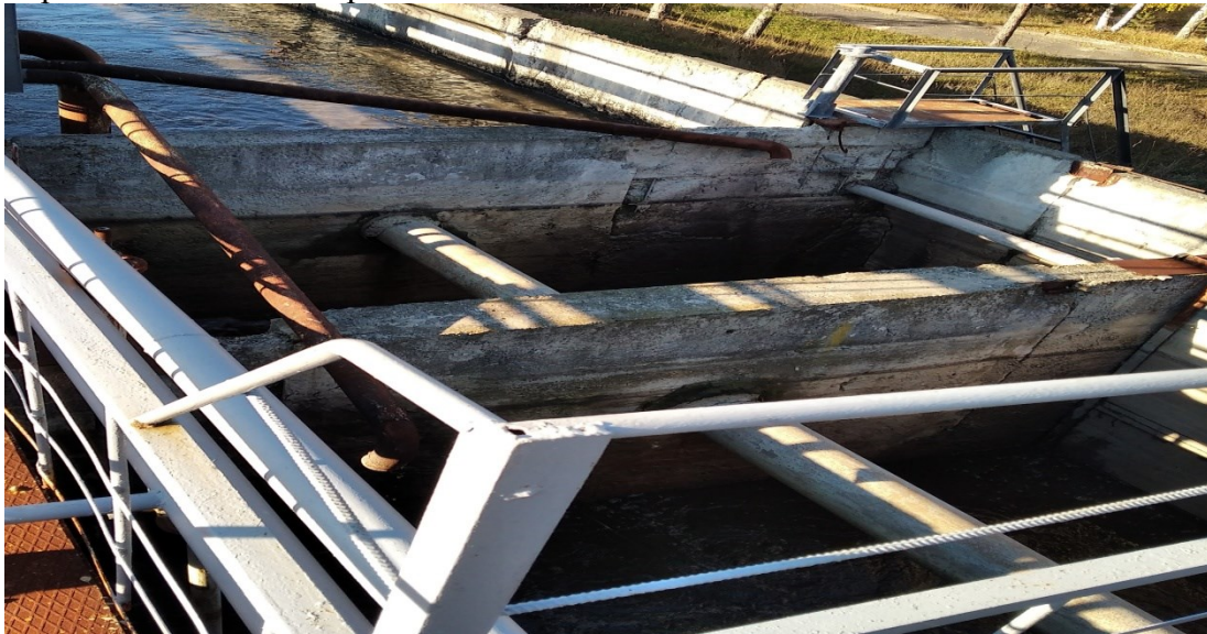
Линия блока емкостей ( первичный отстойник, аэробный стабилизатор, аротенк, вторичный отстойник)
