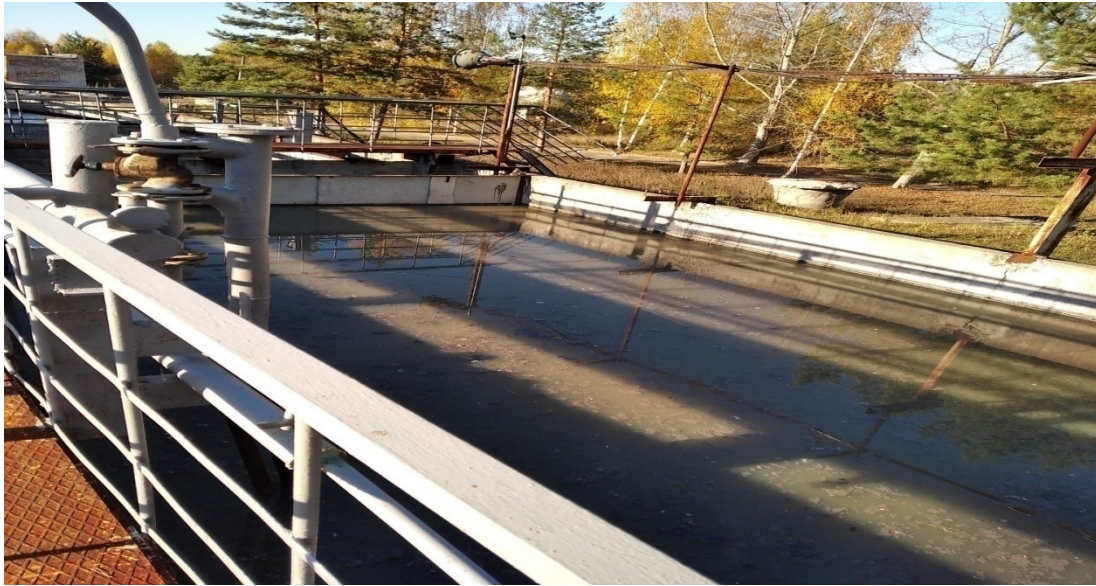
Аэробный стабилизатор
