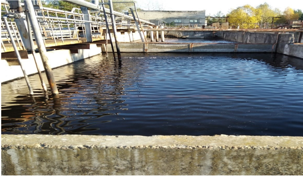
Контактный резервуар
