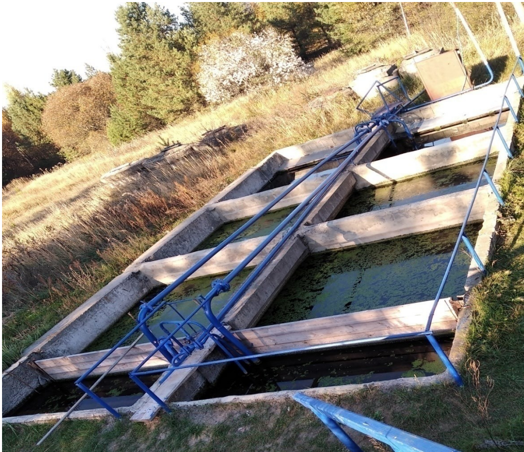
Контактный резервуар
